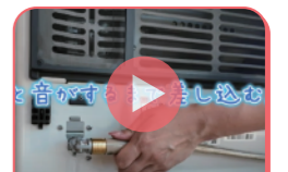
ガスファンヒーターの接続方法
